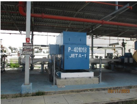
เครื่องสูบน้ำมันไปยังสถานีรับน้ำมันอากาศยานสุวรรณภูมิ
